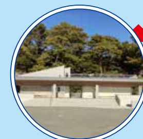
本浜休憩所 [五色のテラス] 太平洋を見渡せる憩いのスポット
